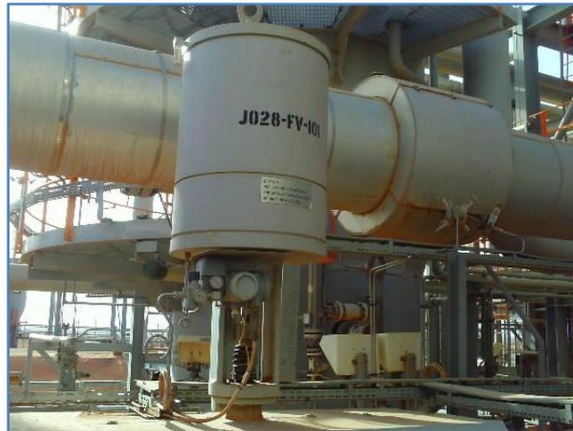
Figure VI.4 : la vanne d'amine J028FV101
