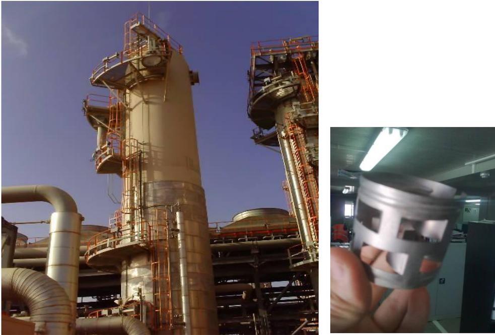
Figure II.4 : la colonne d'absorption d'ISG / Garnissage
