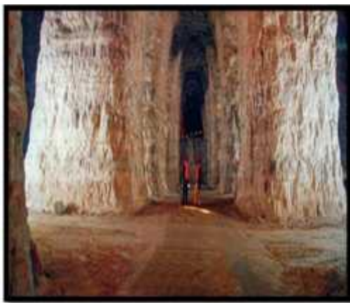
Figure 1.11 : Galeries souterraines à Vaujours [6].
