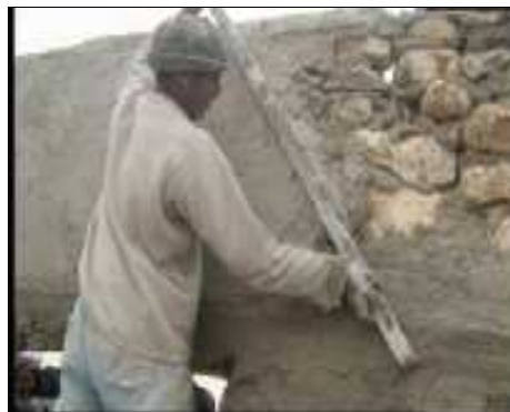
Figure I.37 : Nivellement du mortier de plâtre sur la surface de mur [15].
