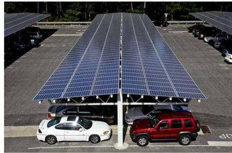
**Figure III.6 b :** Installations photovoltaïques en abris pour parking de STEP (Etats Unis) [57].
