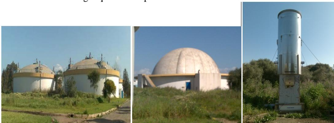
**Figure III.3 :** Digesteurs, gazomètre et torchère de la STEP de Baraki (Alger).
