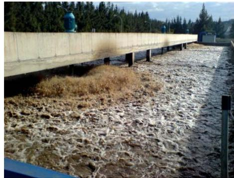
*Figure II.7* : Bassin d'aération, STEP de Boumerdès.
