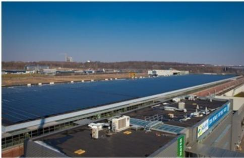
**Figure III.6 a :** Installations photovoltaïques en toiture de STEP (Belgique) [55]
