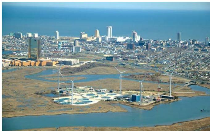
**Figure III.7 :** Installation de système hybride éolien/photovoltaïque/électricité conventionnelle, STEP d'Atlantic City (Etats Unis) [57].
