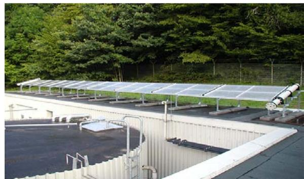
**Figure III.22 :** Photoreacteur tubulaire de 150 m<sup>2</sup>.
