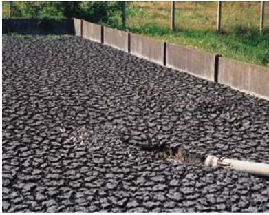
**Figure III. 24** : Lit de séchage solaire à l'air libre [101].
