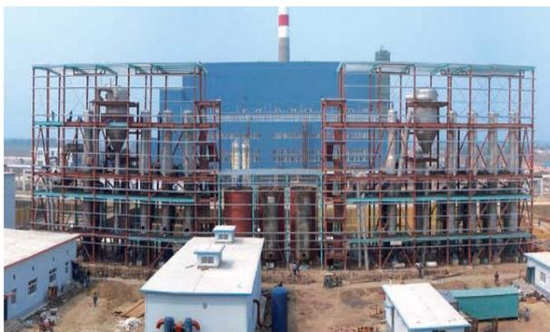
**Figure III.11** : Usine de traitement par distillation à multiple effets [72].
