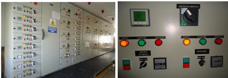
**Figure IV.7 :** Table de contrôle des équipements électriques de la chaîne d'épuration.
