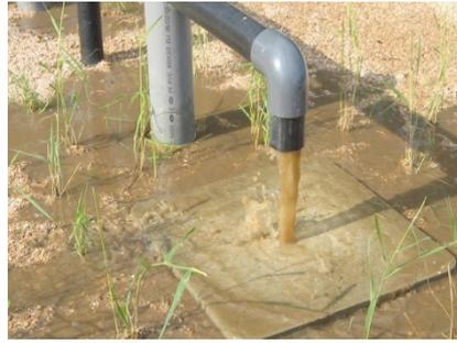
**Figure III. 25** : Lits de séchage solaire plantés de roseaux [102].
