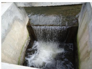
**Figure IV.5 : Rejet des eaux épurées**
