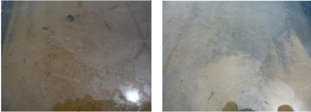
**Figure V.8 :** Dépôts au fond du caisson et surnageant huileux.
