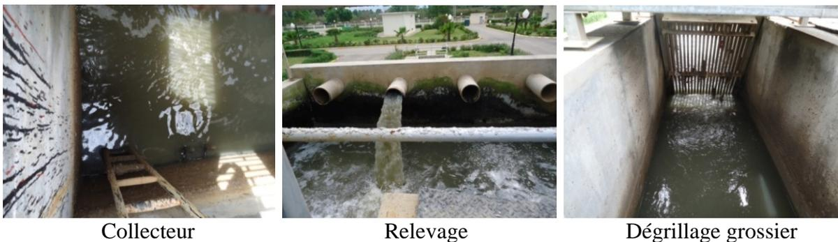
Figure IV.2 : Relevage et prétraitement des eaux usées (étape A et B).
