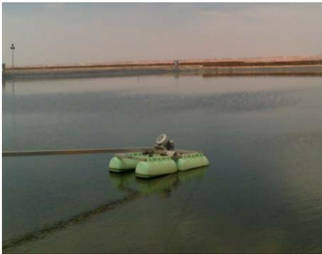
*Figure II.6* : Aérateur de lagune, STEP de Ouargla.
