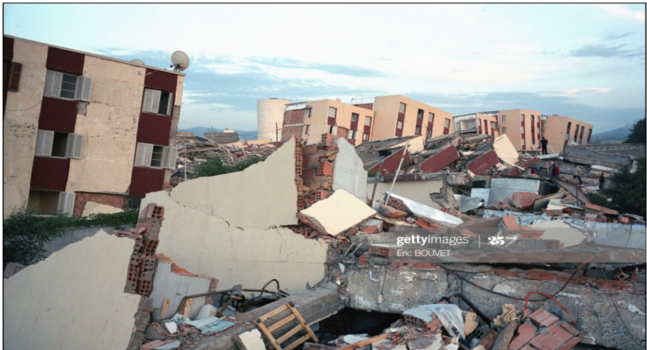
FIGURE 1.1 – Photo prise après le tremblement de terre de Boumerdès (2003)
