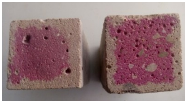
Figure IV.5 : Détection par pulvérisation à la phénolphthaléine
