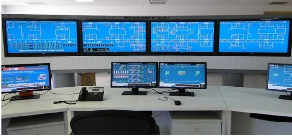
FIGURE 1.4 – Un système SCADA pour les Pipelines de SONATRACH
