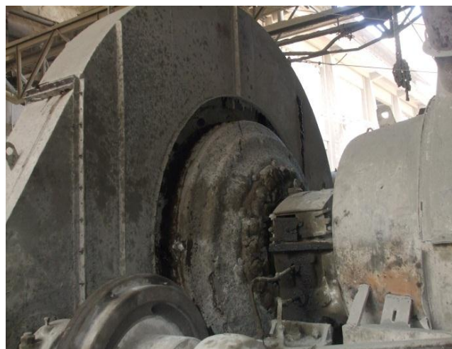
Figure II.8 : LA COURONNE vue sur site
