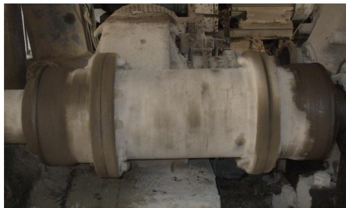
Figure II.4 : ACCOUPLEMENT vue sur site
