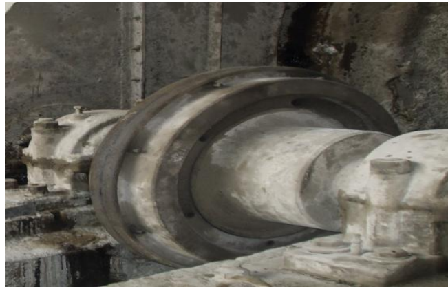
Figure II.7 : ACCOUPLEMENT vue sur site
