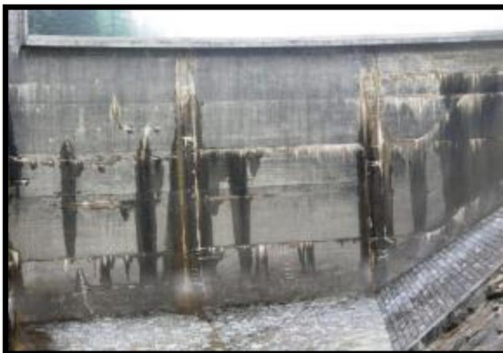
Figure I-13 Apparition d'efflorescence sur le parement aval
