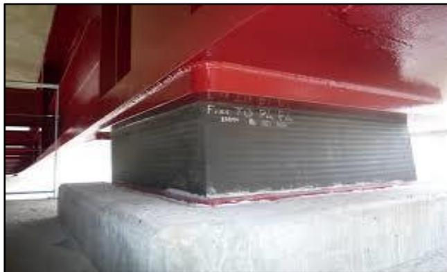
Figure 3-24 Appareil d'appuis en élastomère fretté de type B
