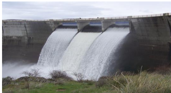
Figure 9 - Evacuateur de crues
