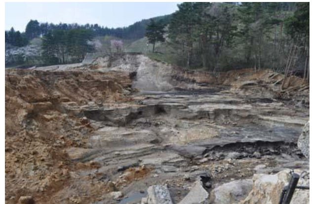
Figure 1-15 Rupture du barrage de Fujinuma (Séisme de Tohoku mars 2011)
