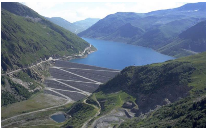
Figure 1-6 Barrage en remblai zoné (Grand-Maison, France)
