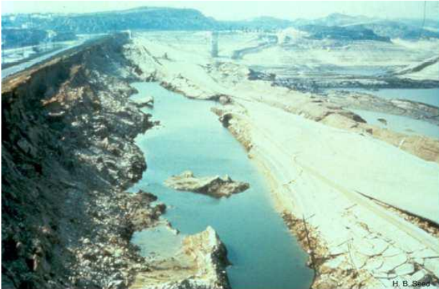
Figure 1-14 Barrage de Lower Van Norman après le séisme de San Fernando en 1971
