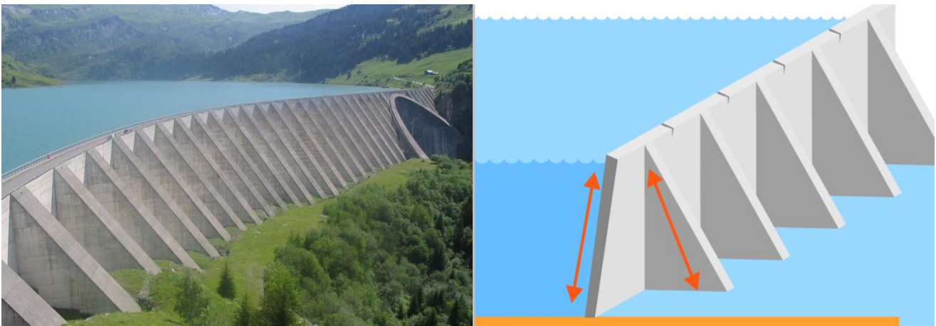
Figure 1-4 Barrage à contreforts (Roselend, France)
