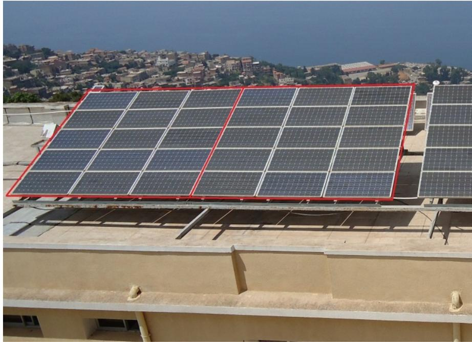
**Figure I.9.** Champ PV formé de 2 x 15 modules branché en série
