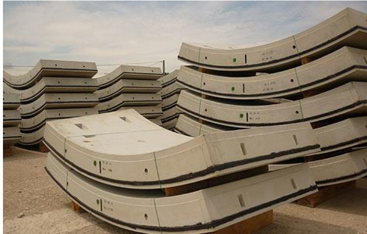
Figure III.8 : Les voussoirs préfabriqués du soutènement provisoire
