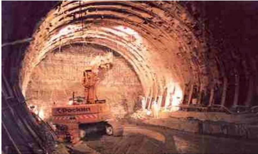
Figure II.1 : Creusement à pleine section
