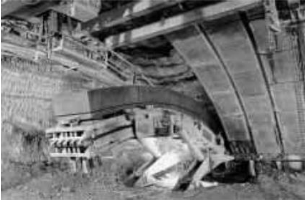
Figure III.13 : Exemple de pose d'une voûte active
