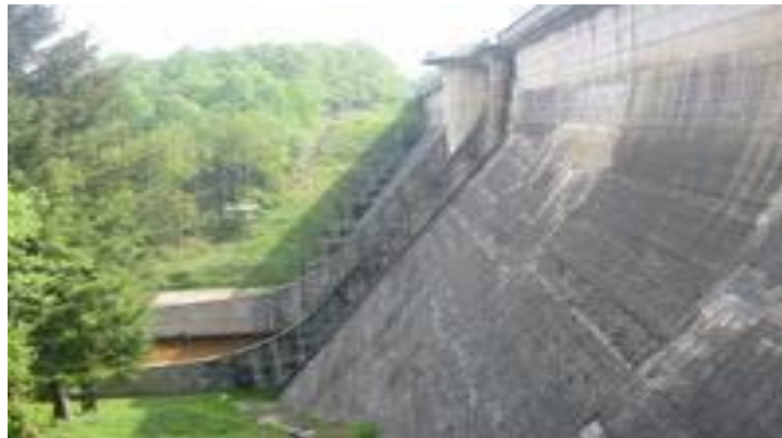
Figure II.3 : Barrage de Vassivière[11]
