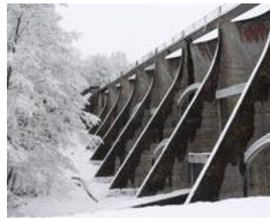
Figure II.7 : Barrage de Faux-la-Montagne
