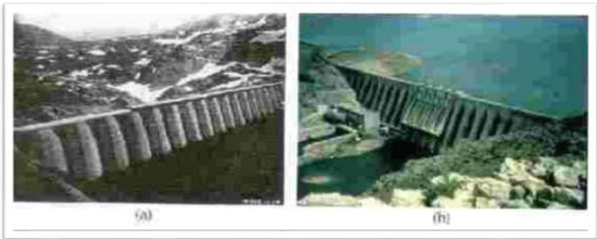
**Figure.1.17:**Barrage à contreforts de Lucendro (a) et d'Al Massira (Maroc) (b)
