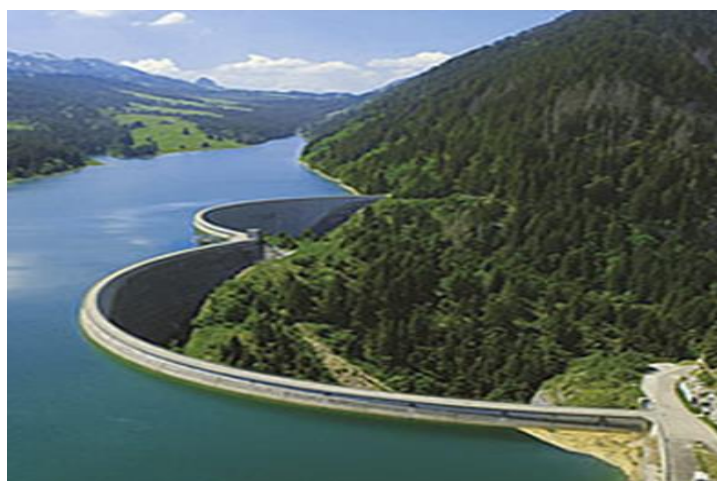
Figure 1-2 Barrage voûte
