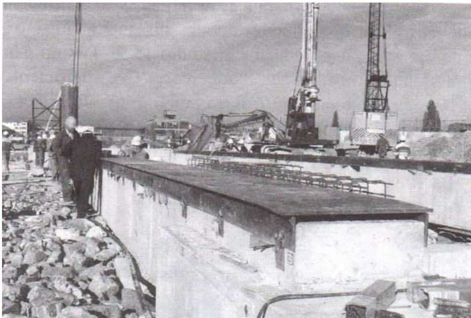
Figure VII.6 – Système de glissement sur longrines [3]
