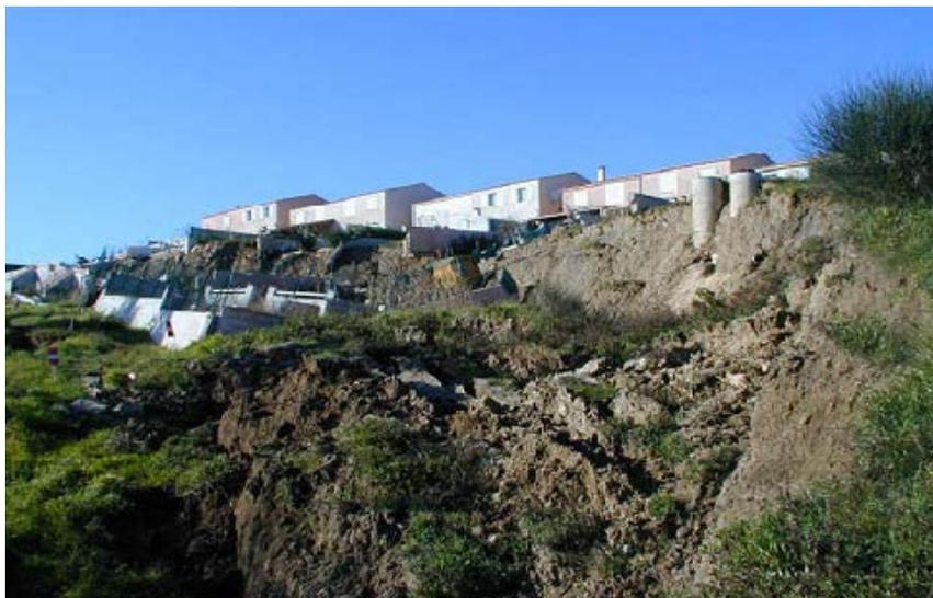
**Fig.2.3.** Construction au sommet de talus
