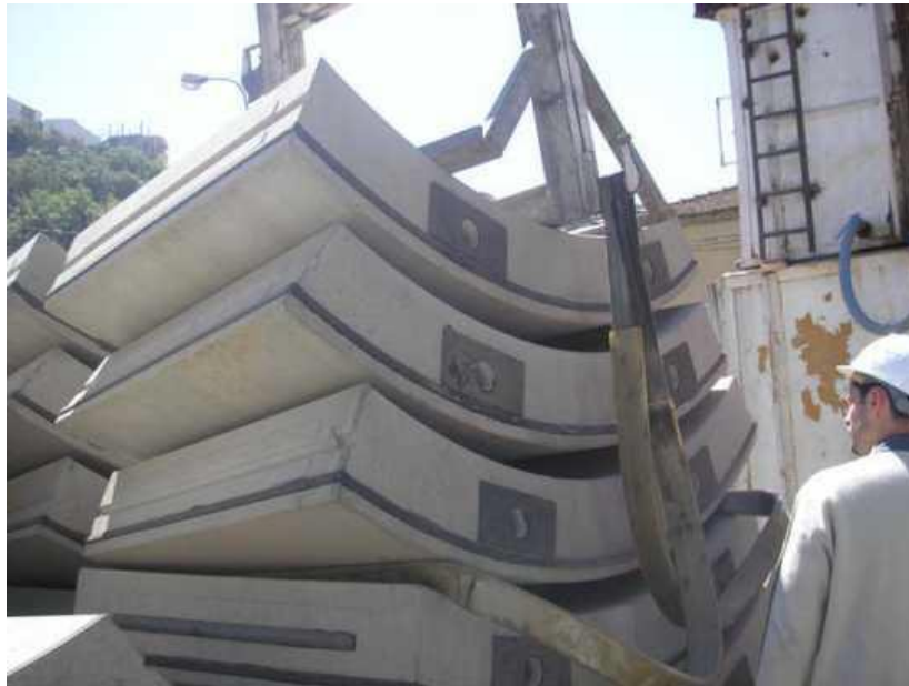
Figure III.12: voussoir préfabriqué.
