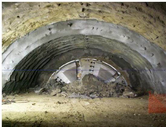
Figure III.6:image montrant le creusement grâce a un bouclier pressurisé.
