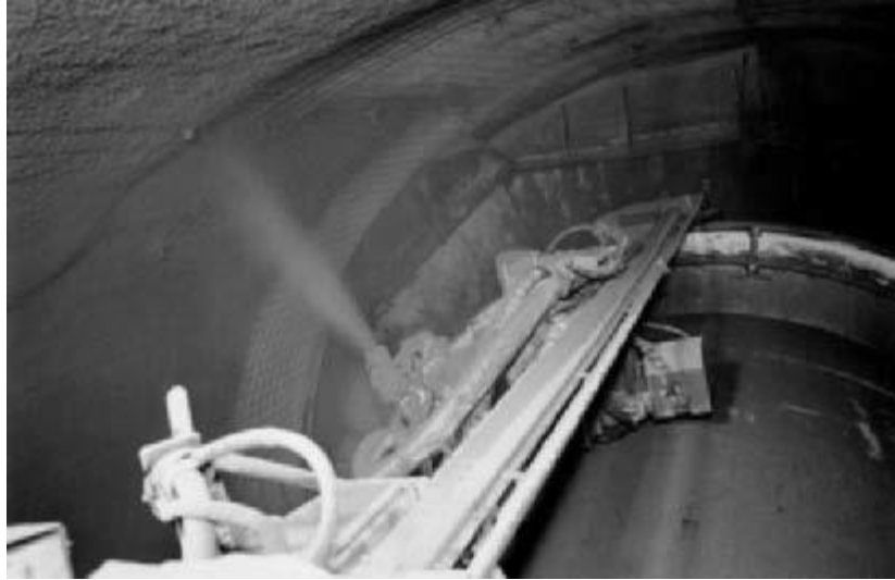
Figure III.10: image montrant l'application du béton projeté vue de l'intérieur.
