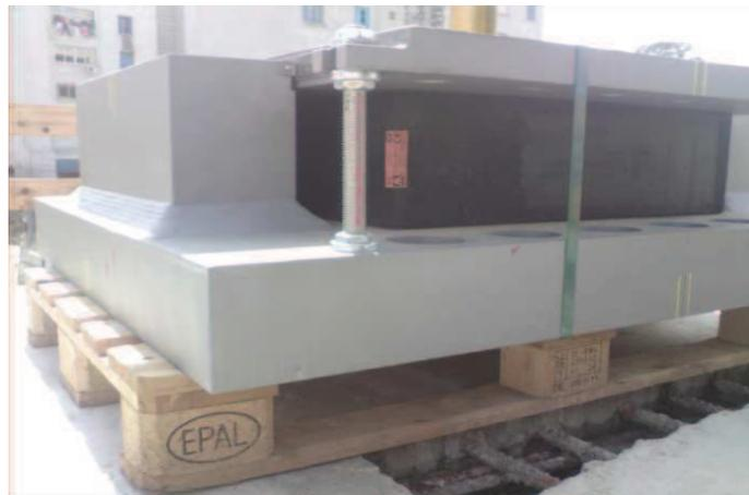
Figure 10 : Appareil d'appui sur la pile 8
