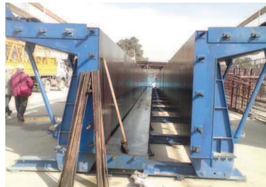
Figure 5 : Coffrage métallique modulaire
