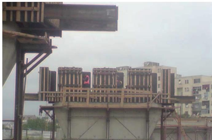
Figure 11 : Installation du coffrage de l'entretoise sur la pile 4.
