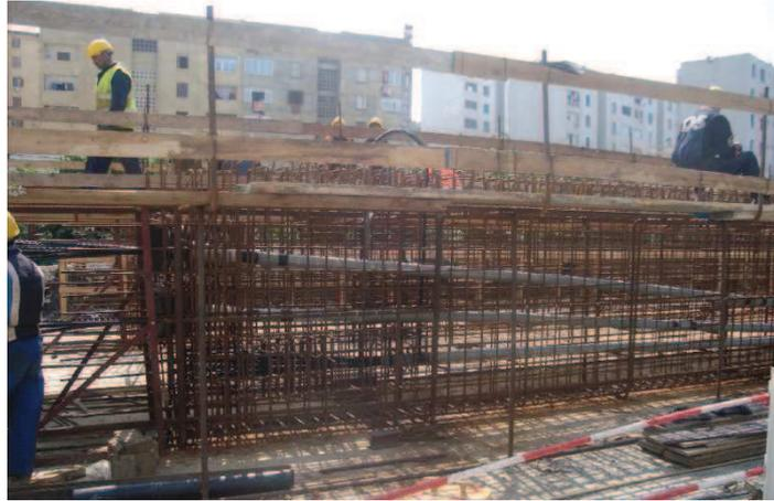
Figure 6 : Cage d'armatures avec gaines
