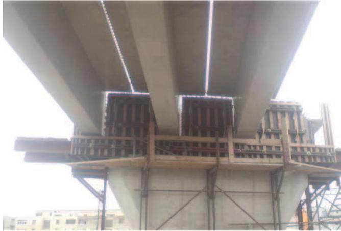
Figure 12 : Pose des poutres
