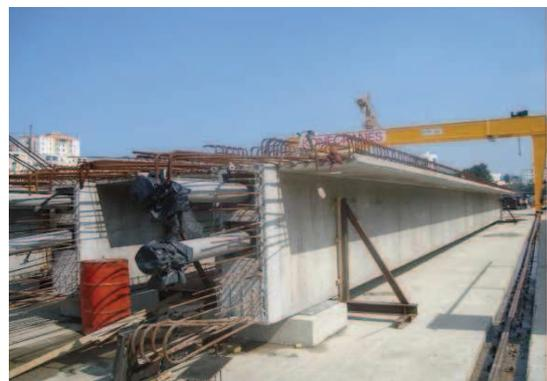
Figure 8 : Poutres préfabriquées dans la zone de stockage
