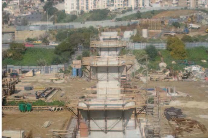
Figure 9 : échafaudage pour l'installation des appuis au niveau des piles
