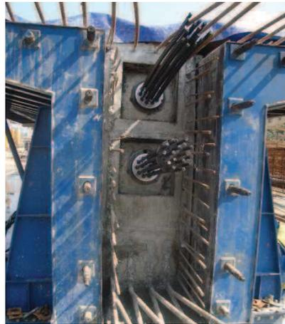
Figure 7 : Coffrage de la poutre
