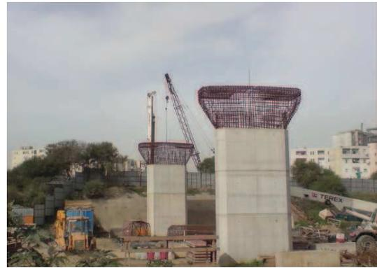
Figure 4 : Ferrailage du chevêtre
