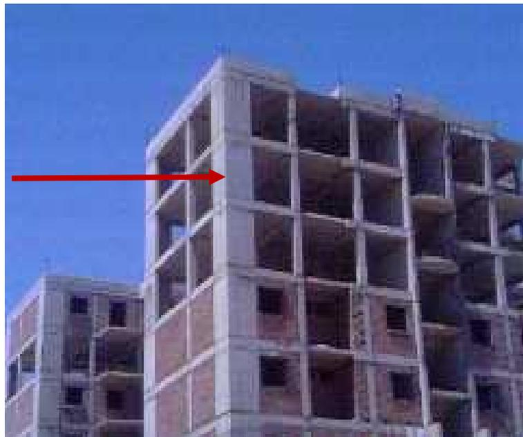
*Figure II.1 Bâtiment Contreventé par des voiles en ailerons*
