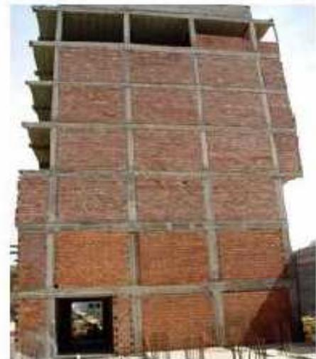
**Figure 1.3** Ossature contreventée par portique remplissage en maçonnerie rigide
