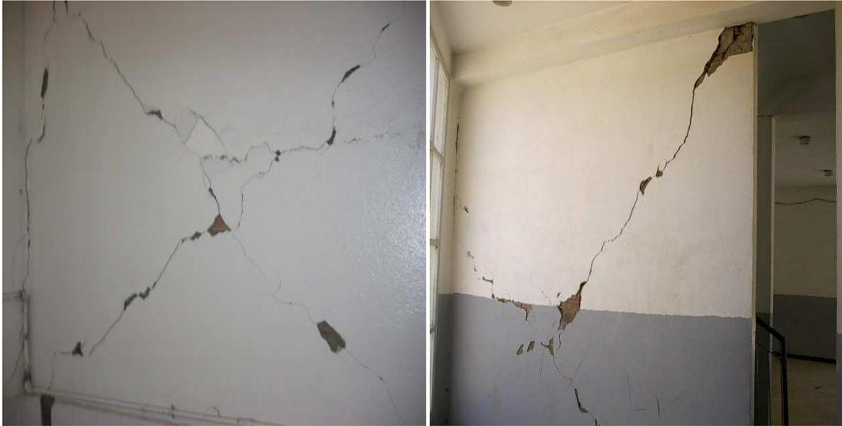
*Figure III.3 La fameuse fissure en X ; Séisme de BOUMERDES 21/mai/2003*
