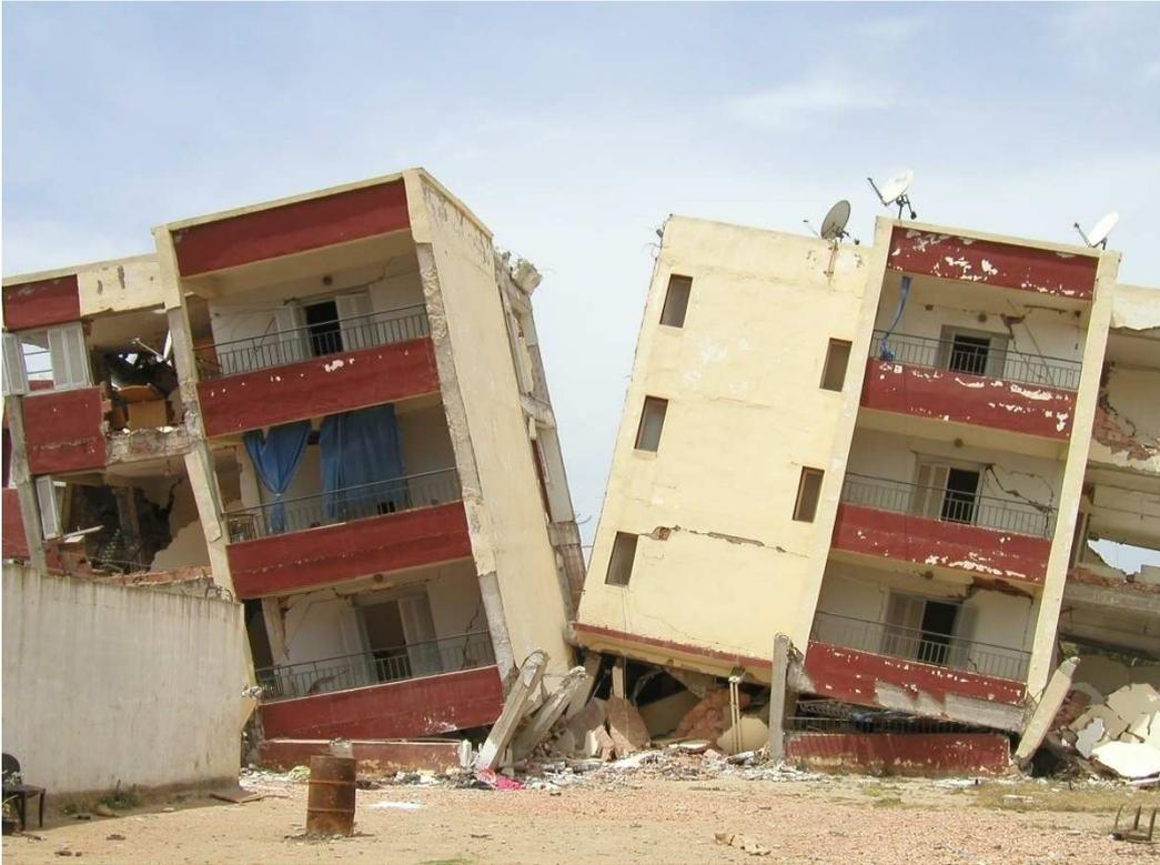
*Figure II.8 Dommages dus à la torsion. Séisme de BOUMERDES, Algérie 2003*
