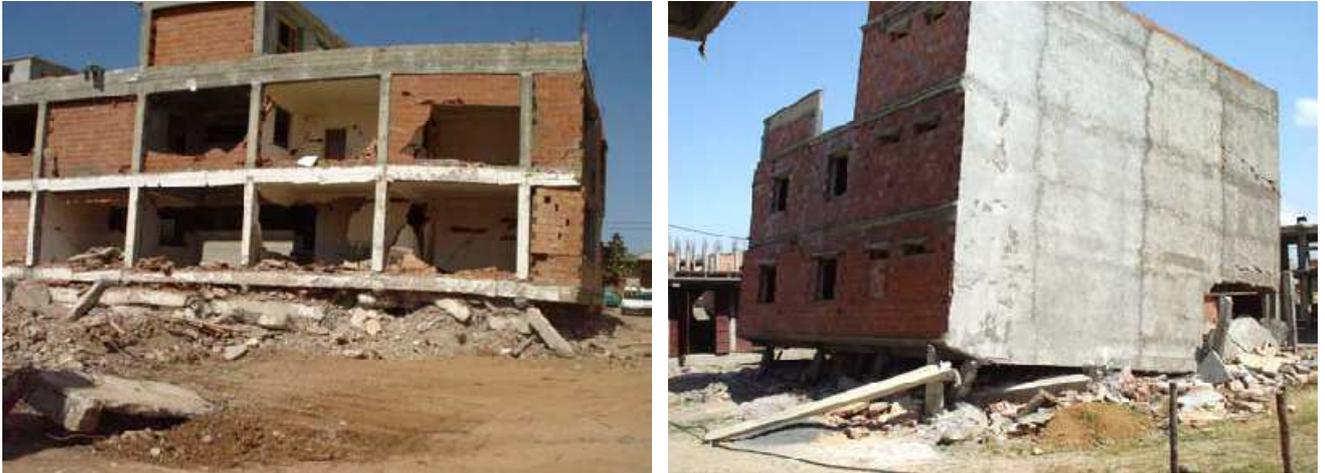
*Figure III.2 Rupture par formation des rotules plastiques au niveau des poteaux*
