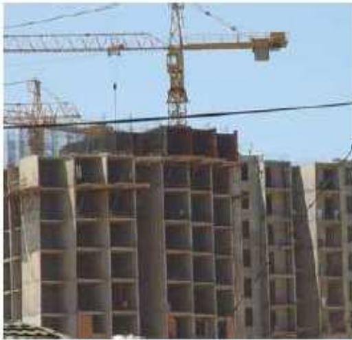
**Figure 1.2** Ossature contreventée par voile en béton armé
