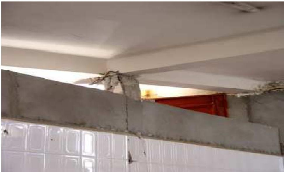
*Figure III.4 : destruction des poteaux à cause du fonctionnement en « poteau-court »*
