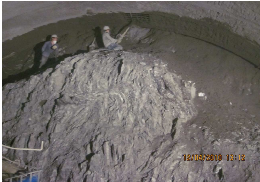
Figure III.8 Application du béton projeté au front et sur les parois à l'aide de la lance manuellement :
