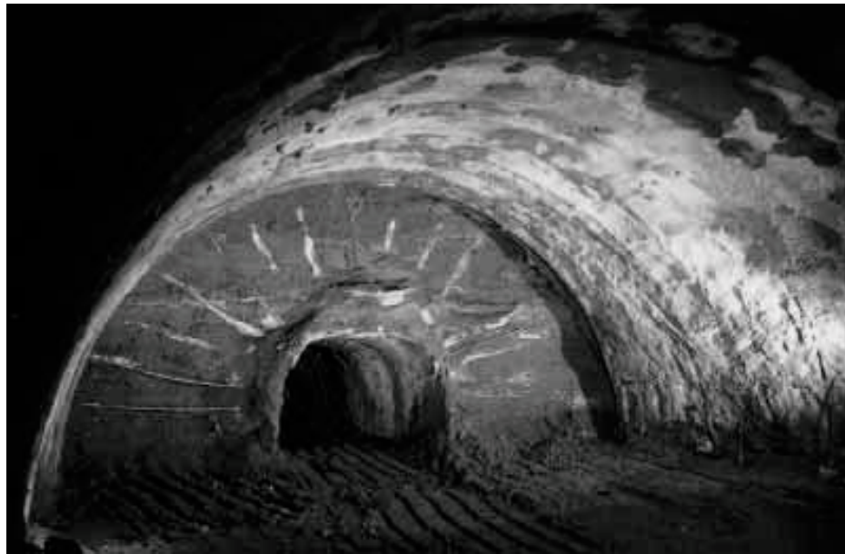
Figure II-1 Exemple de galerie de reconnaissance
