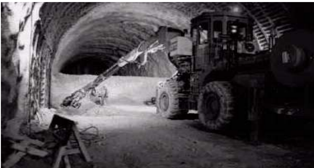
Figure III.2 Creusement en demi-section
