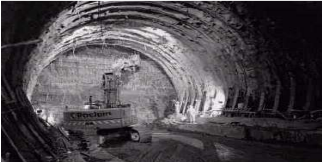
Figure III.1 Creusement en pleine section
