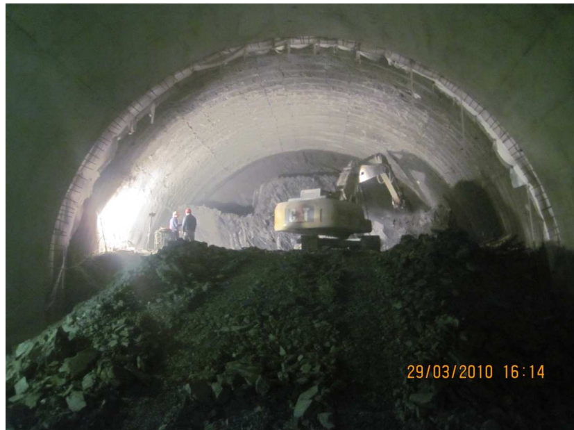
Figure IV.9 Excavation en 3 gradins: calotte avec merlon, Stross I supérieur, Stross II inférieur et un radier provisoire.
