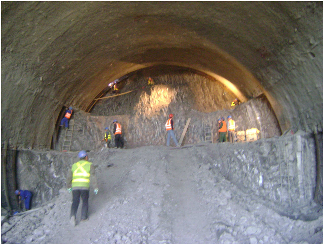
Figure III.10 Excavation en trois gradins
