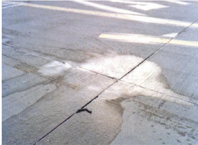
Figure II.18 : Pompage sur joints de construction et joints de retrait sur voie de circulation
