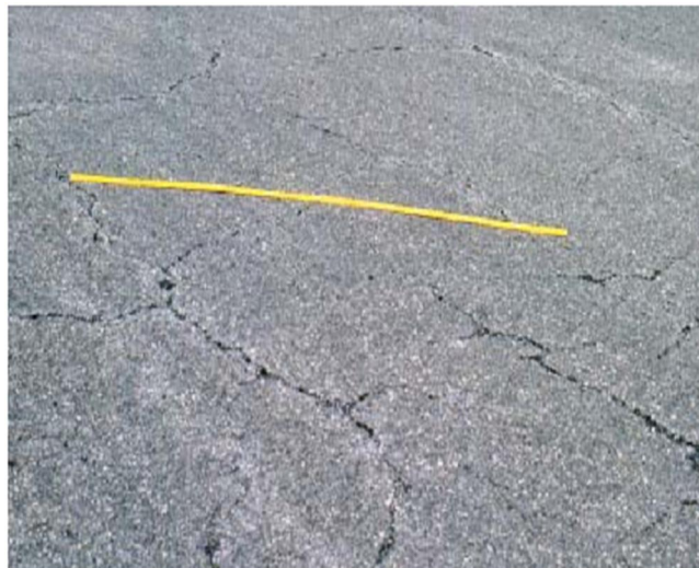
Figure II.10 : Faiénçage de retrait
