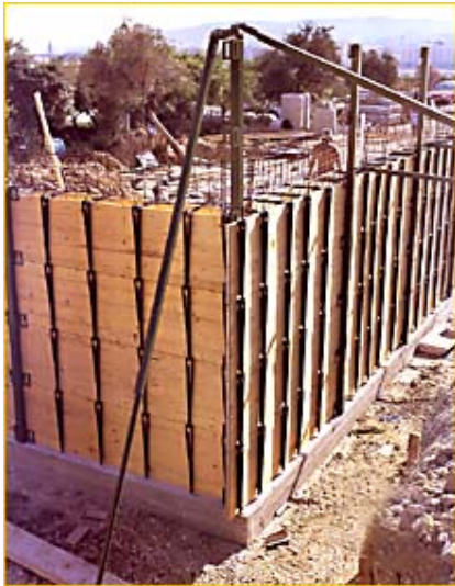
Fig.III-1 : Coffrage traditionnel en bois [3]
