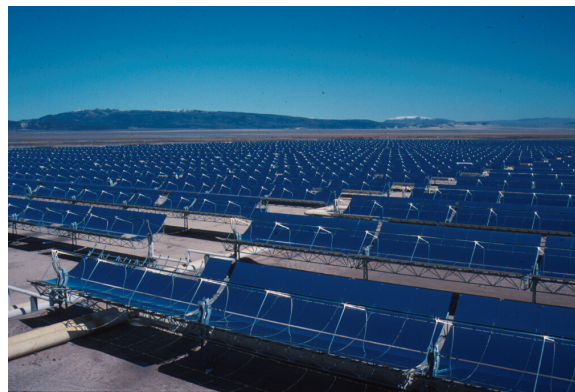
FIGURE 1.2 – concentrateur Cylindro-parabolique
