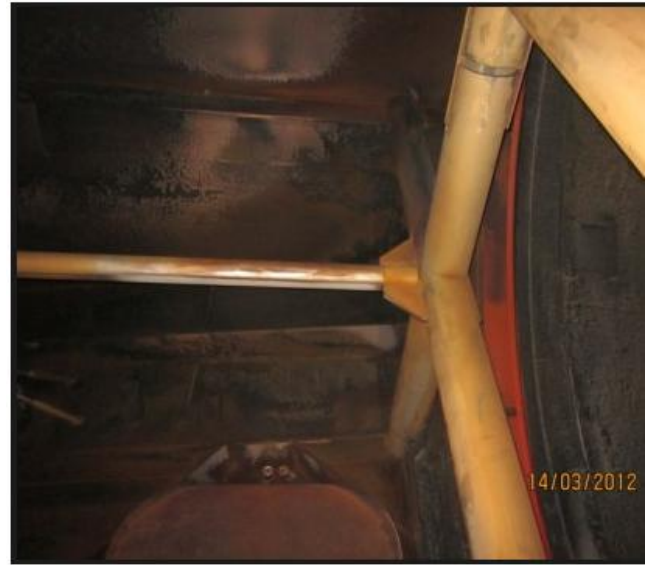
Figure 5.10: tubes de soutien interne du condenseur
