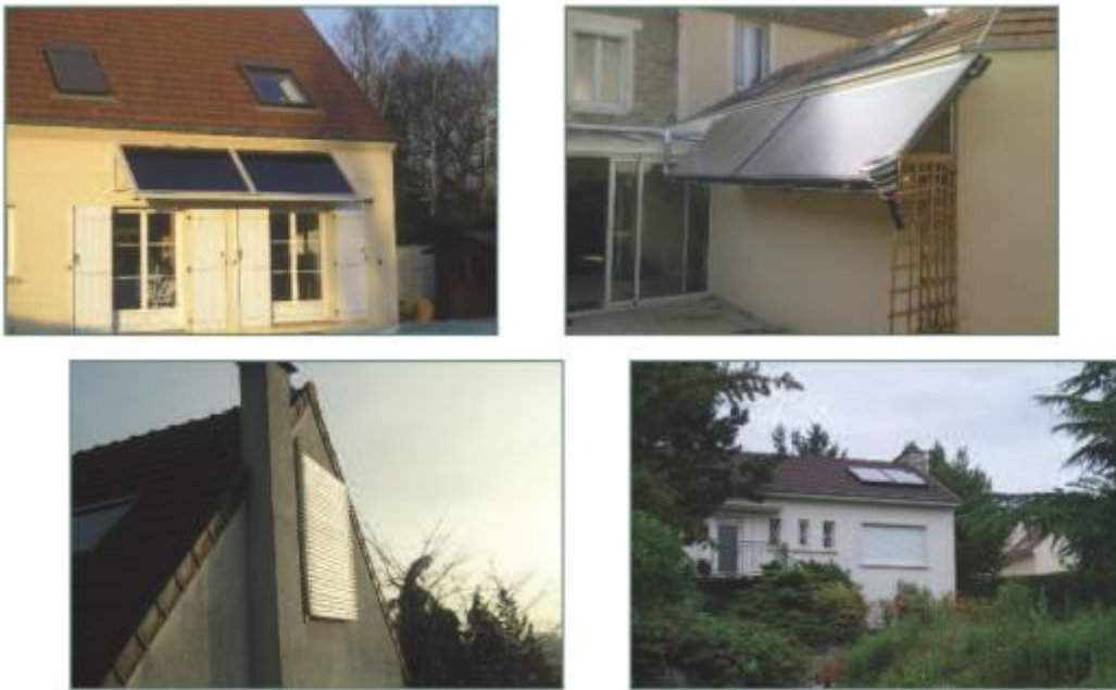
Figure 2.7. Exemples d'installation de capteurs d'énergie solaire thermique
