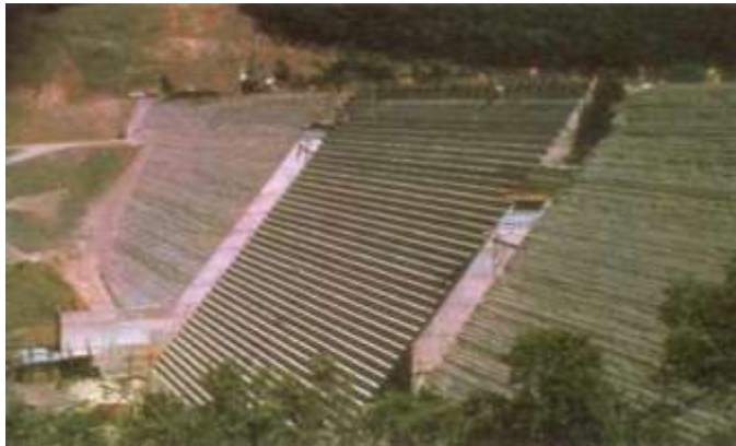
Figure.1.11: Barrage poids en BCR des Olivettes (France) (H = 35 m).
