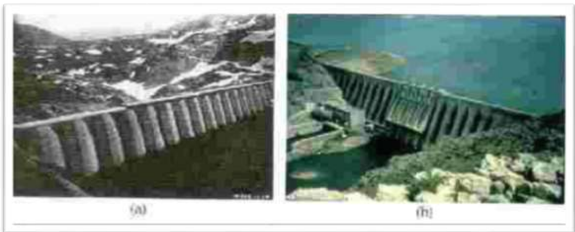
Figure.1.16: Barrage à contreforts: différentes forme de la tête des contreforts:(a) à tête Ronde;(b) à tête en forme de marteau;(c) à tête en forme de T; (d) à dalle planes.
