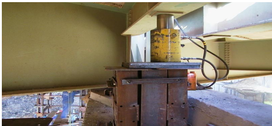
Figure V.14 Pose des vérins hydrauliques sur le support
