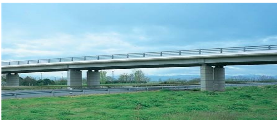
Figure I.2 Pont en béton armé
