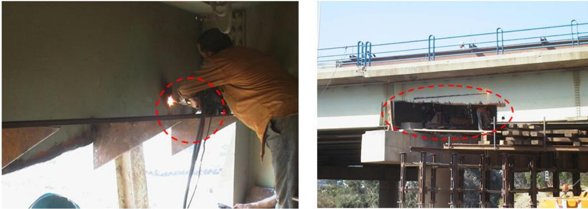
Figure V.29 Découpage de la partie endommagée de la poutre de rive
