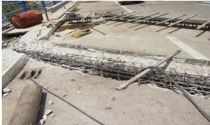
Figure V.37 Démolition de béton de la dalle de part et d'autre des joints
