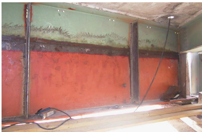
Figure V.33 Renforcement de la poutre
