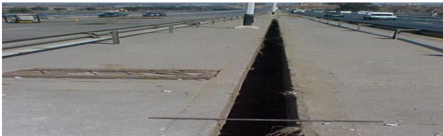
Figure V.3 Rotation des travées
