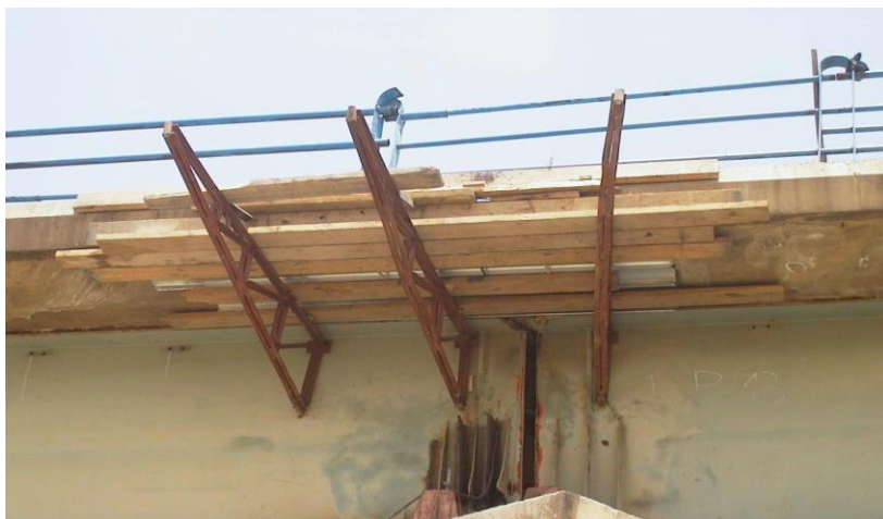
Figure V.41 Mise en place du coffrage des corniches
