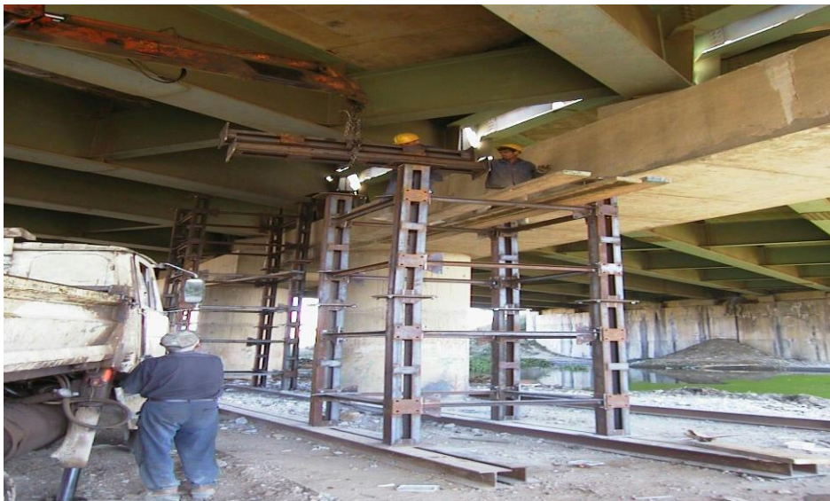
Figure V.9 Montage des palets métalliques
