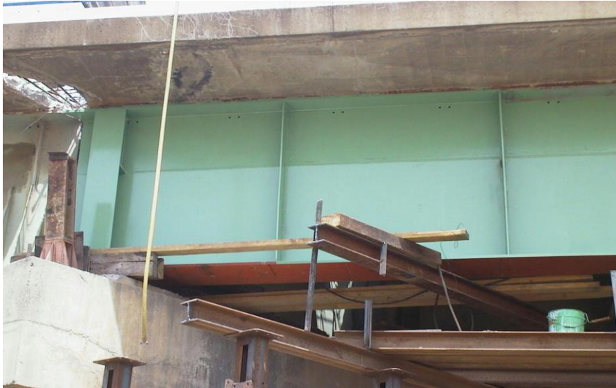
Figure V.34 Application de la peinture protection
