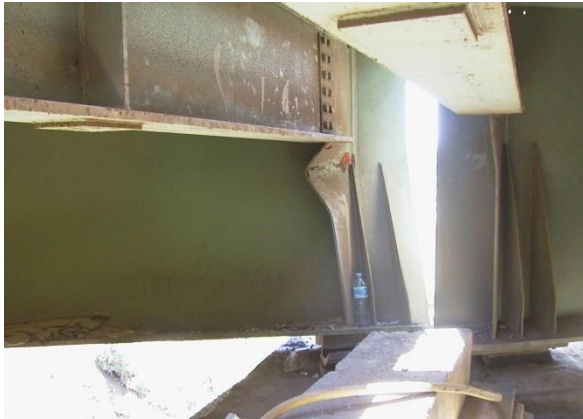
Figure V.5 Endommagement des poutres
