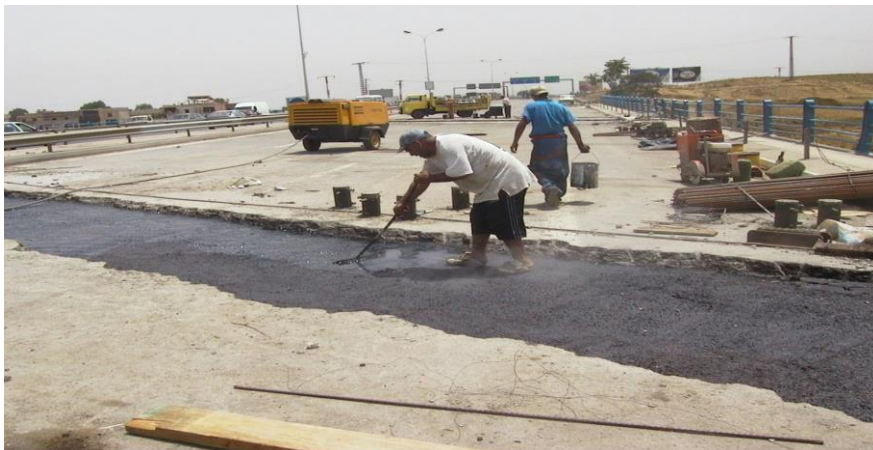
Figure V.40 Exécution de la chape d'étanchéité
