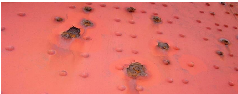
Figure II.5 : Rivets attaqués par la rouille
