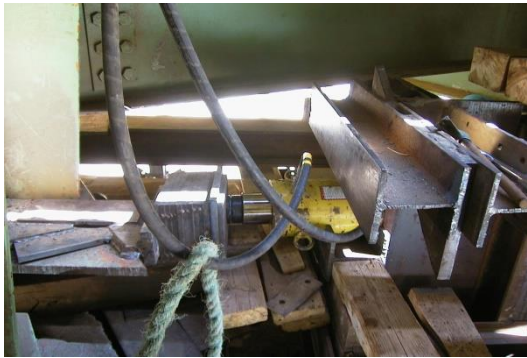
Figure V.21 Exécution de l'opération de ripage par poussée en utilisant le vérin
