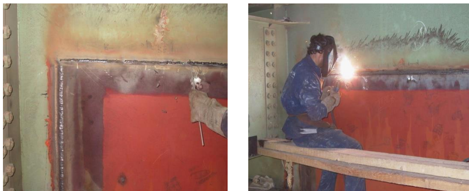
Figure V.31 Soudure de la nouvelle partie de la poutre
