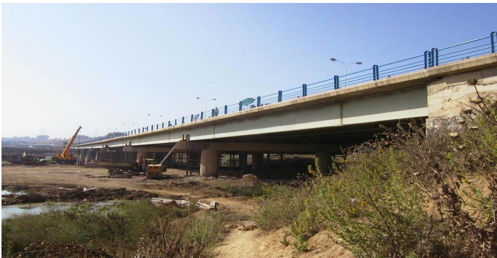
Figure V.1 Viaduc au PK 11+080 sur oued El-Harrach
