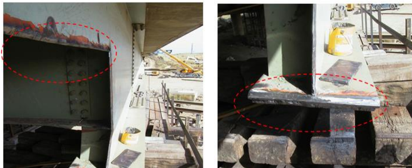
Figure V.30 Exécution de chanfreins sur le tronçon de poutre
