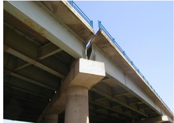
Figure V.5 Endommagement des poutres
