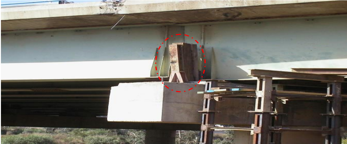
Figure V.11 Exécution des butées transversales
