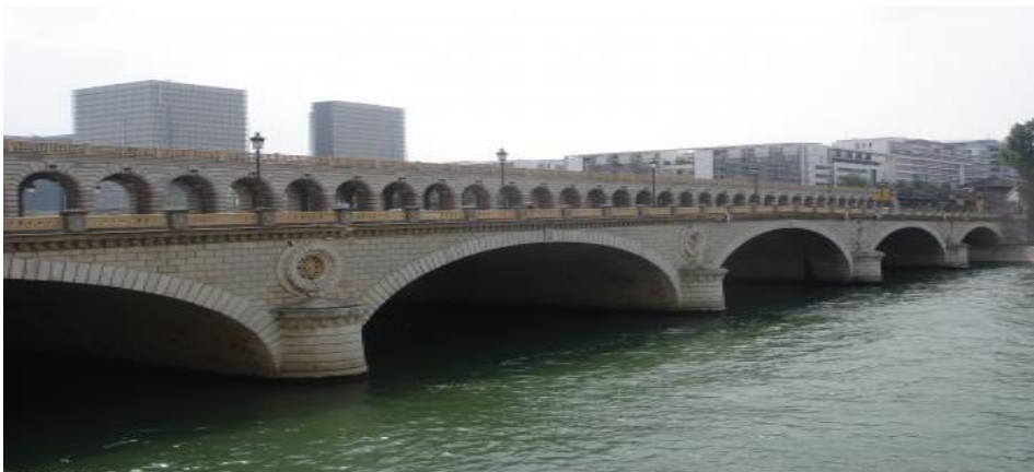
Figure I.1 Pont en maçonnerie
