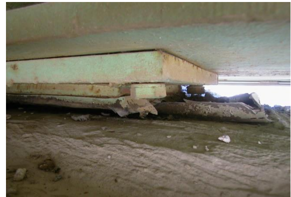
Figure V.6 Ecrasement des appareils d'appuis
