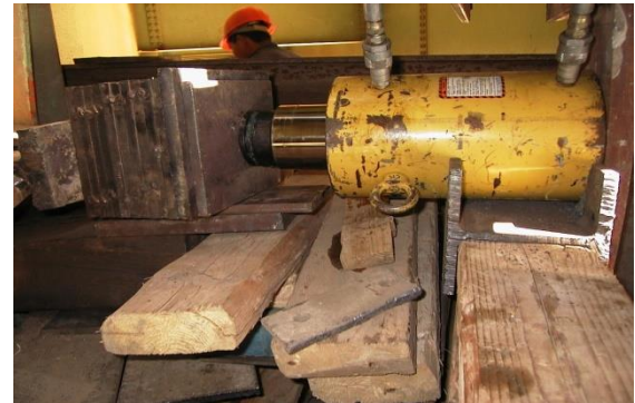
Figure V.21 Exécution de l'opération de ripage par poussée en utilisant le vérin
