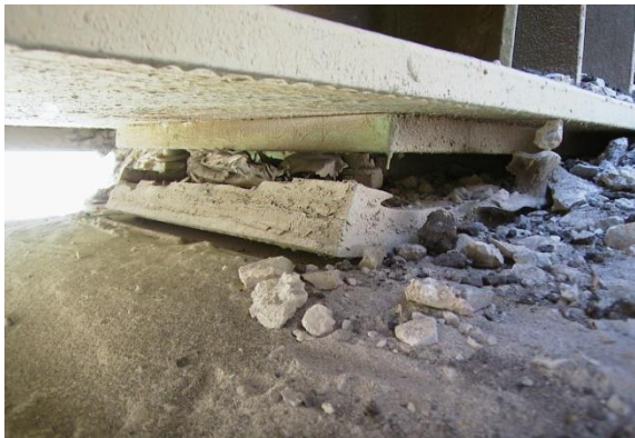
Figure V.6 Ecrasement des appareils d'appuis
