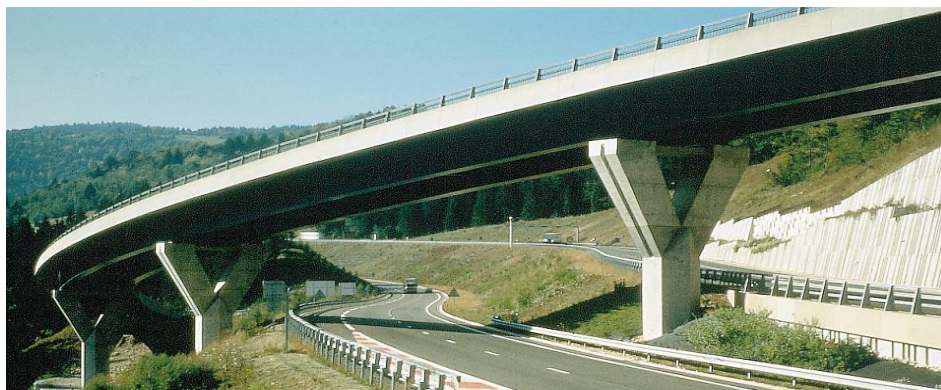
Figure I.4 Pont à poutre
