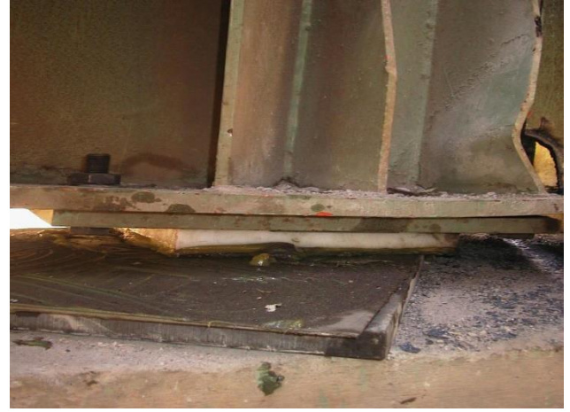
Figure V.23 Mise en place du tablier sur les plaques en polyamide
