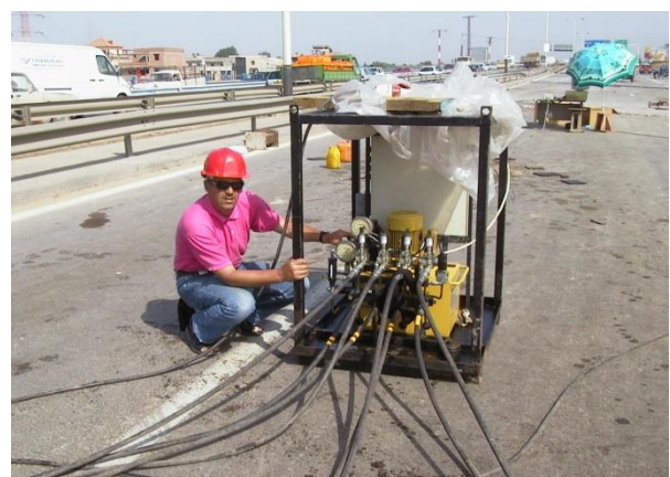
Figure V.12 Vérins utilisés pour l'opération
