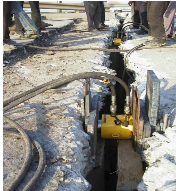
Figure V.24 Ripage longitudinal du tablier
