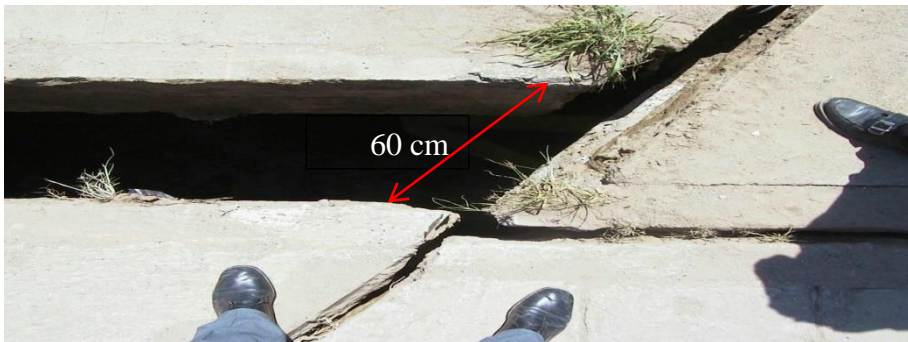
Figure V.2 Déplacement transversal de 15 à 60 cm au niveau des piles
