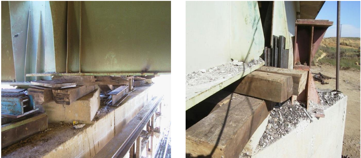
Figure V.15 Exécution de l'opération de vérinage et calage par phase
