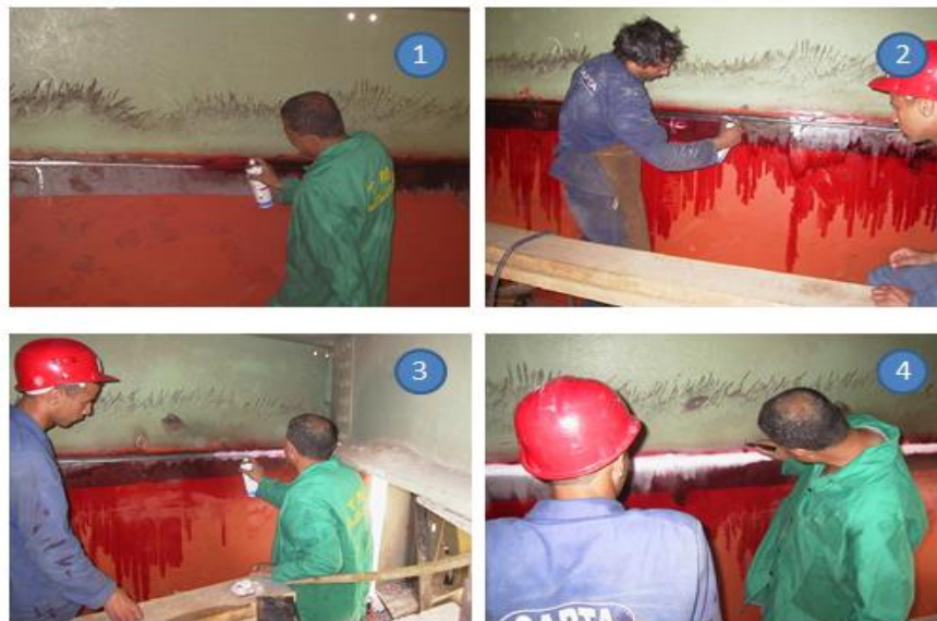
Figure V.32 Inspection des soudures
