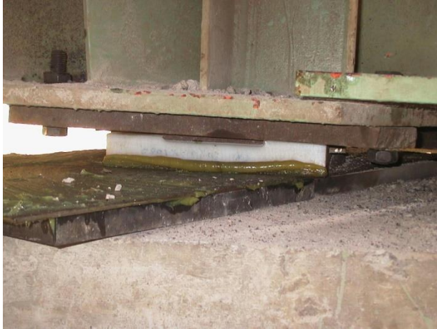
Figure V.23 Mise en place du tablier sur les plaques en polyamide
