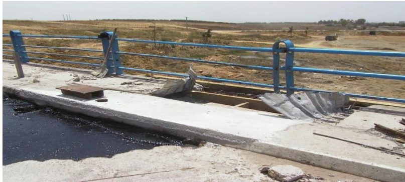
Figure V.42 Réalisation des gardes corps
