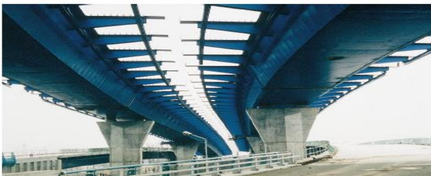
Figure I.7 Pont à poutres caissons
