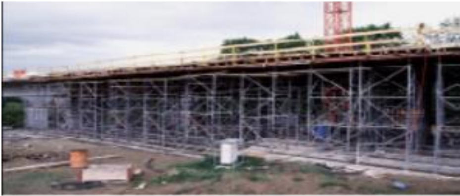
Figure I.10 Construction sur étaievements
