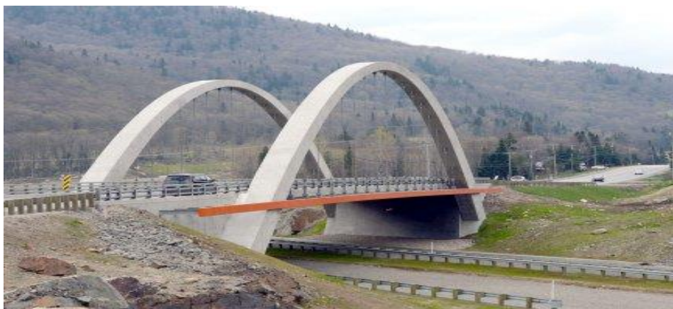
Figure I.5 Pont en arc
