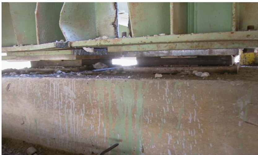
Figure V.36 Remplacement des appareils d'appuis
