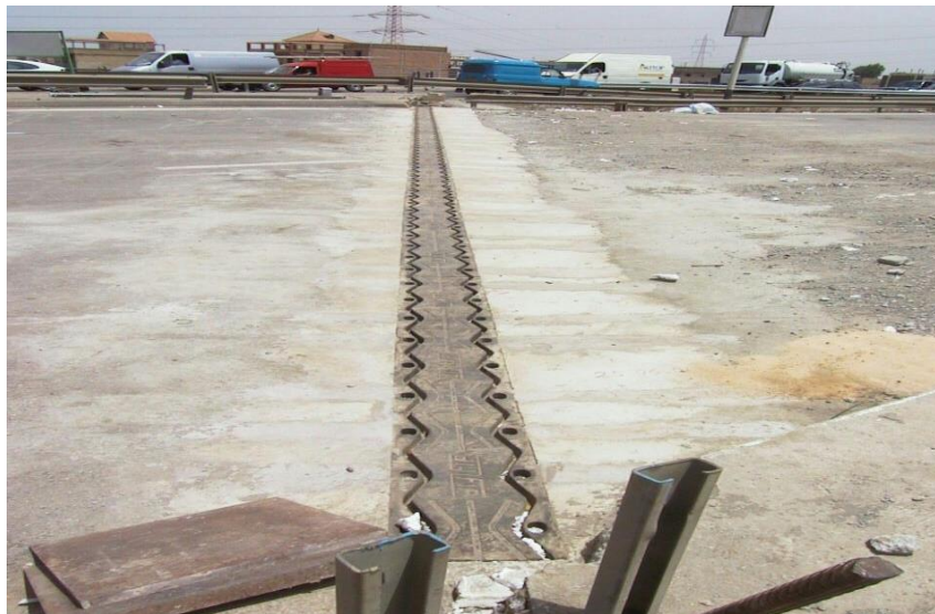
Figure V.38 Bétonnage de la dalle autour du joint
