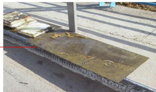
Figure V.22 Plaque en inox et plaque en polyamide
