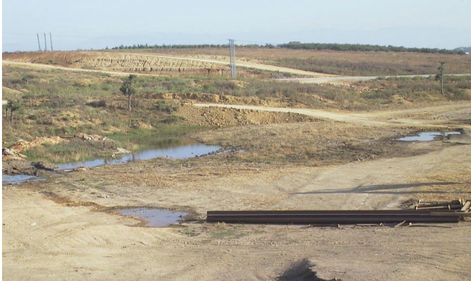
Figure V.8 Réalisation des accès à l'ouvrage
