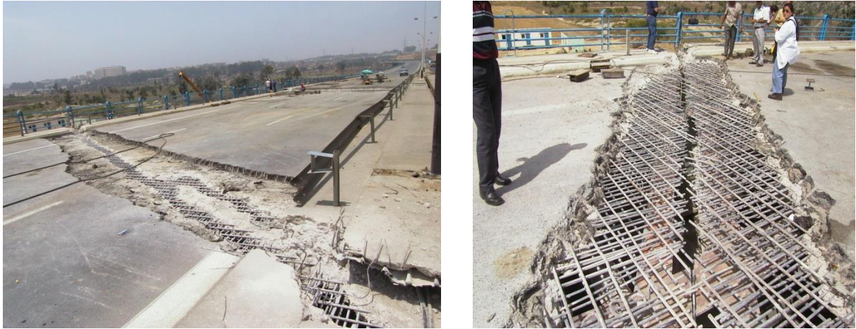
Figure V.13 Suppression de la continuité de la dalle
