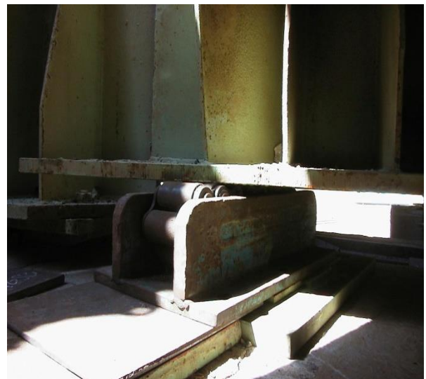
Figure V.20 Mise en place du tablier sur rouleaux
