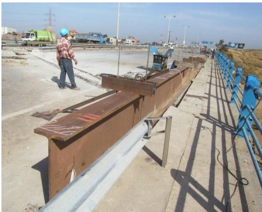
Figure V.28 Mise en place de la poutre de renforcement
