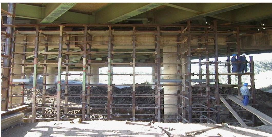
Figure V.10 Montage des profilés HEB 180 pour supporter le tablier métallique
