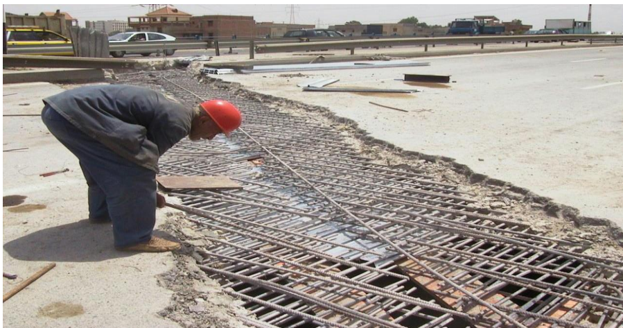
Figure V.39 Pose des barres de recouvrement
