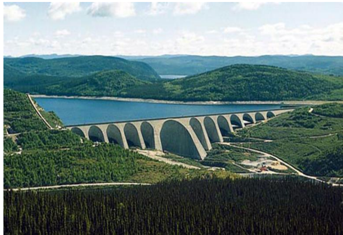
Figure 1-3 Barrages à contreforts
