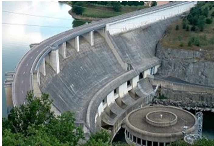
Figure 1-4 Barrage mixte (poids- voûtes)
