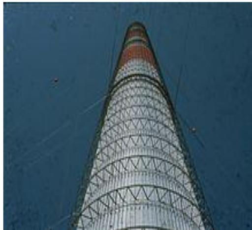
**Figure. 1.8** Image de la cheminée de la centrale de Manzanares via le vitrage de la toiture du collecteur.
