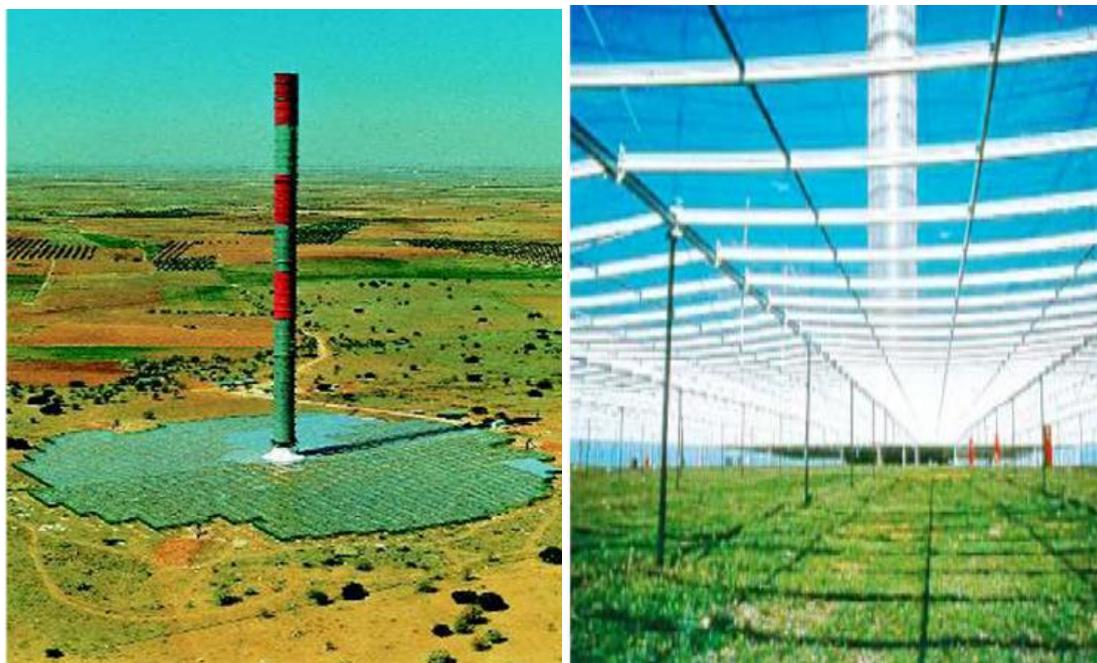
**Figure 2.1** Photos du prototype de Manzanares : (a) vue globale de l'installation ; (b) vue du collecteur [9].
