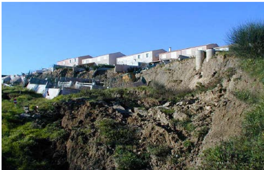
Fig.2.3. Construction au sommet de talus
