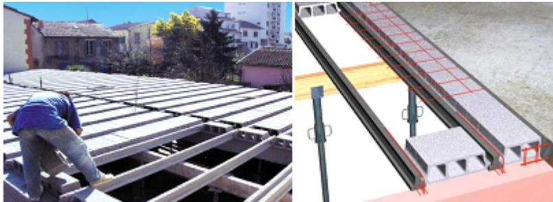
Figure 2.1: Mise en œuvre d'un plancher à corps creux
