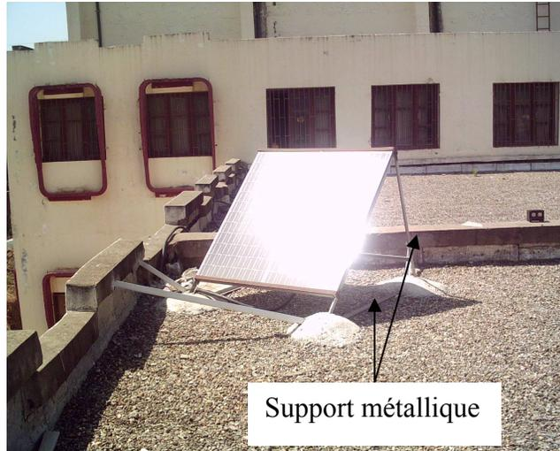
Figure V.4: Installation des panneaux photovoltaïques
