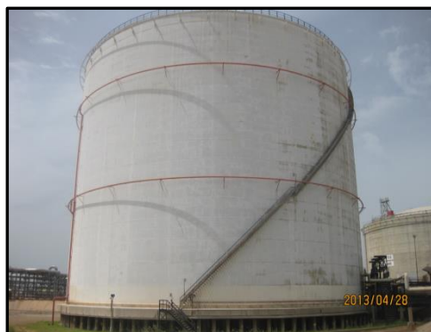
Figure II.2 Bac de stockage de GNL du complexe GLIK (Skikda).
