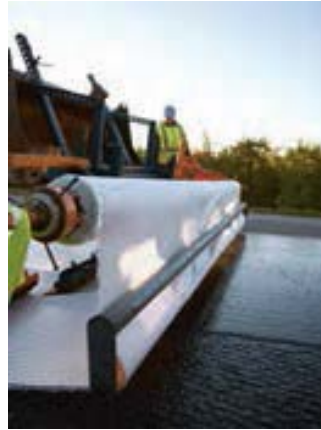
Fig. 2.6 Application d'un géosynthétique anti-fissuration de chaussée
