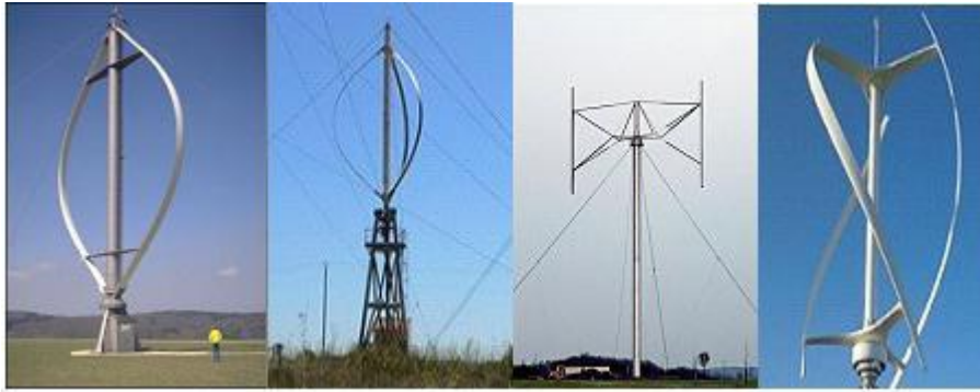
Figure I. 10 Différentes déclinaisons des éoliennes de type Darrieus.[9]
