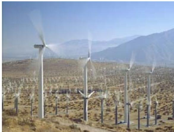
**Fig.1.3 Ferme d'éoliennes à axe horizontal**
