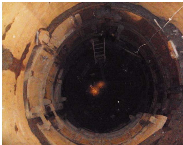
Figure III.2 : vue au dessus de puisard.
