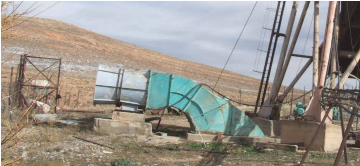
Figure V.7: Ventilateur Aspirant de Chaabet-El-Hamra (Type 1300 HDM).
