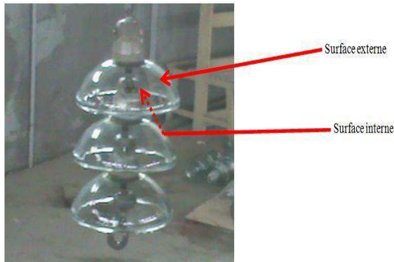
Figure III.9 : Surfaces interne et externe d'un élément de la chaîne d'isolateur.
