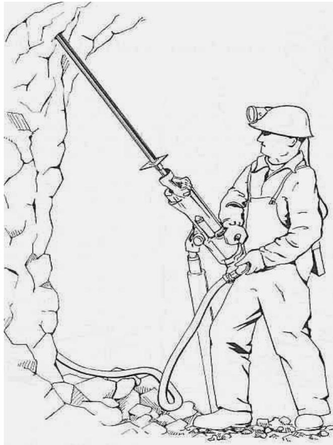
**FigIII-6.** Mise en place d'un boulon « Split set ».
