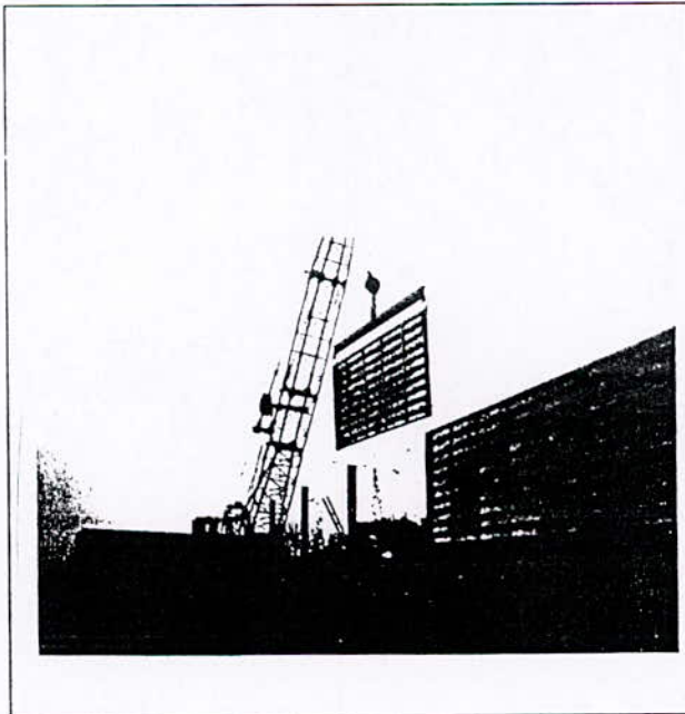
Figure. 1.4 : Ecran à structure porteuse non intégrée.
