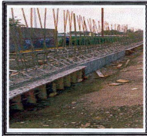
**Photo 5.2 : Base d'écran acoustique en béton armé**
