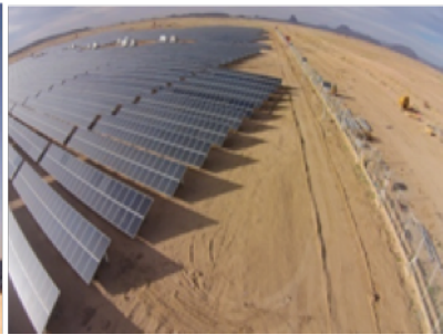
Centrale de Tamanrasset
