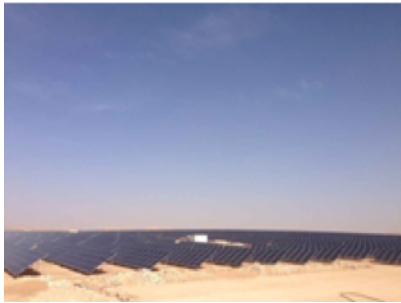
Centrale de Laghouat
