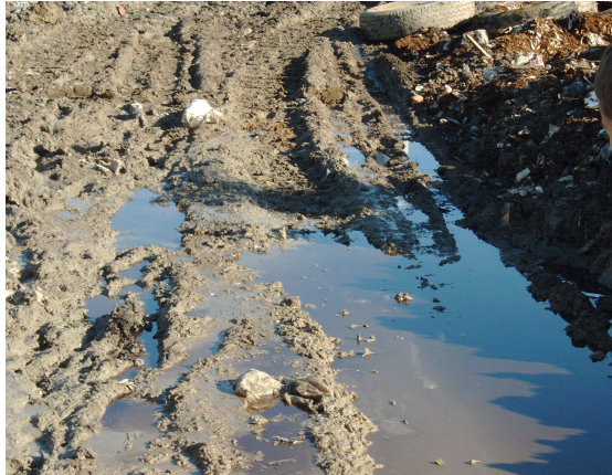
Figure III.3 : Absence de drainage des lixiviats
