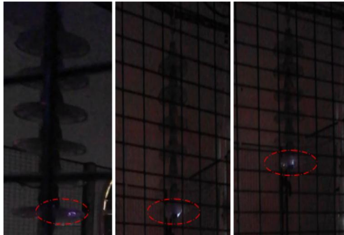
Figure I.8. Activité des arcs partiels pour une tension de 22 kV
