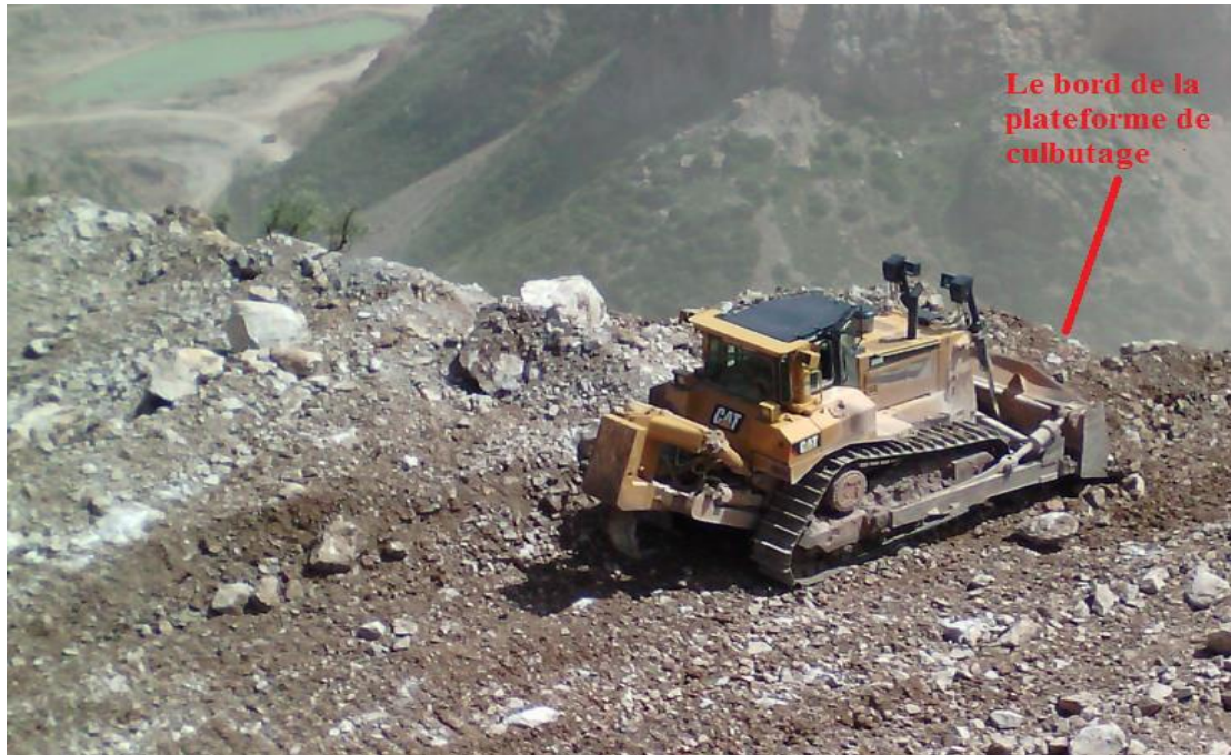
Figure II.6 : Le bulldozer utilisé pour le déblocage de la roche minière.
