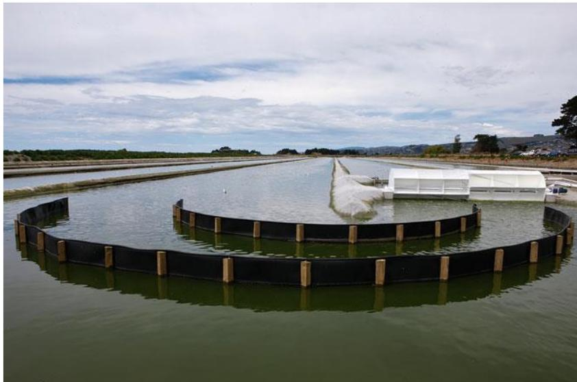
**Figure III.5 : L'un des quatre procédés de traitements des eaux usées dans les CAHR (1,25 ha) avec addition du  $\text{CO}_2$  à Christchurch, Nouvelle-Zélande [47].**
