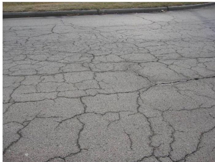
Figure I.9. Fissures de fatigue [Buttlar et al. 2018]
