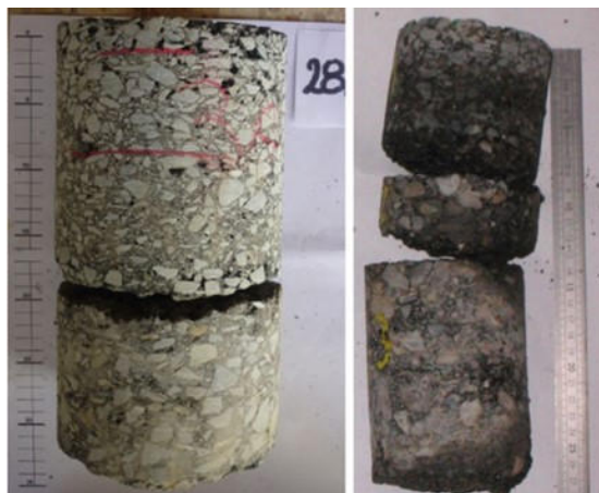
Figure I.8. Carottes provenant de chaussées bitumineuses épaisses, montrant un décollement entre les couches.
