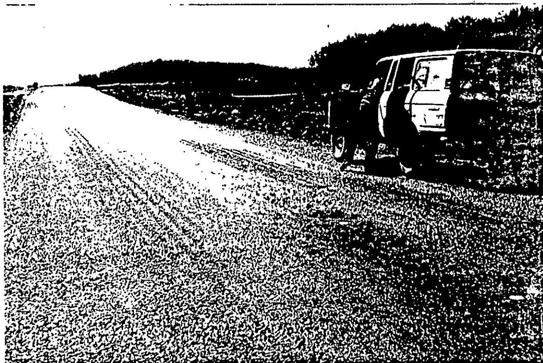
Chaussée en tuf.
